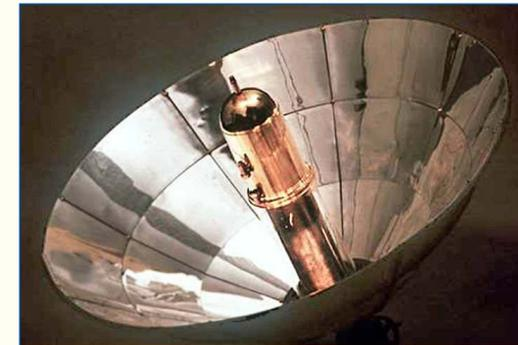
Un miroir parabolique de Mouchot avec le générateur de vapeur au centre
