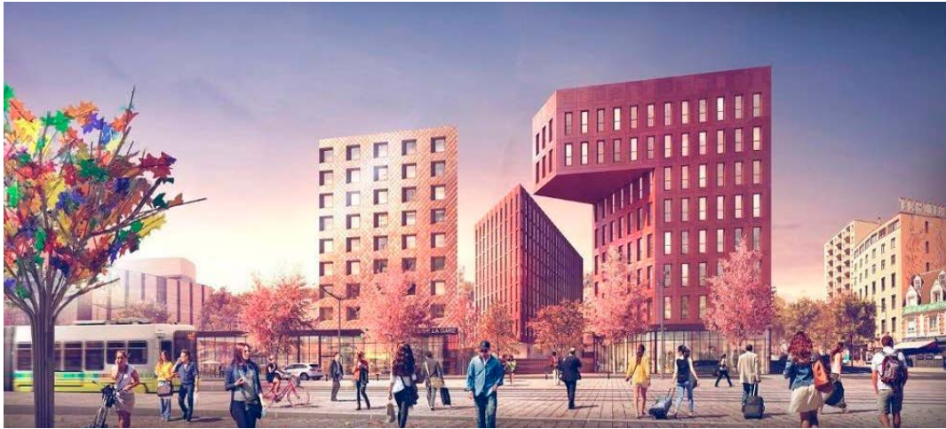
L'îlot Poste Weiss est située face à la gare SNCF, en bordure de l'esplanade de France. Construit sur l'ancien site de production de la chocolaterie Weiss, il accueille le siège de la CPAM de la Loire. Architecture ECDM (Emmanuel Combarel - Dominique Marrec) - Architecte d'exécution : Jacques Varennes.
